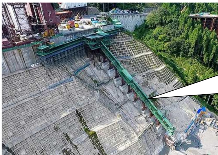
足羽川ダム本体建設工事に設置された急傾斜用 SICON®
