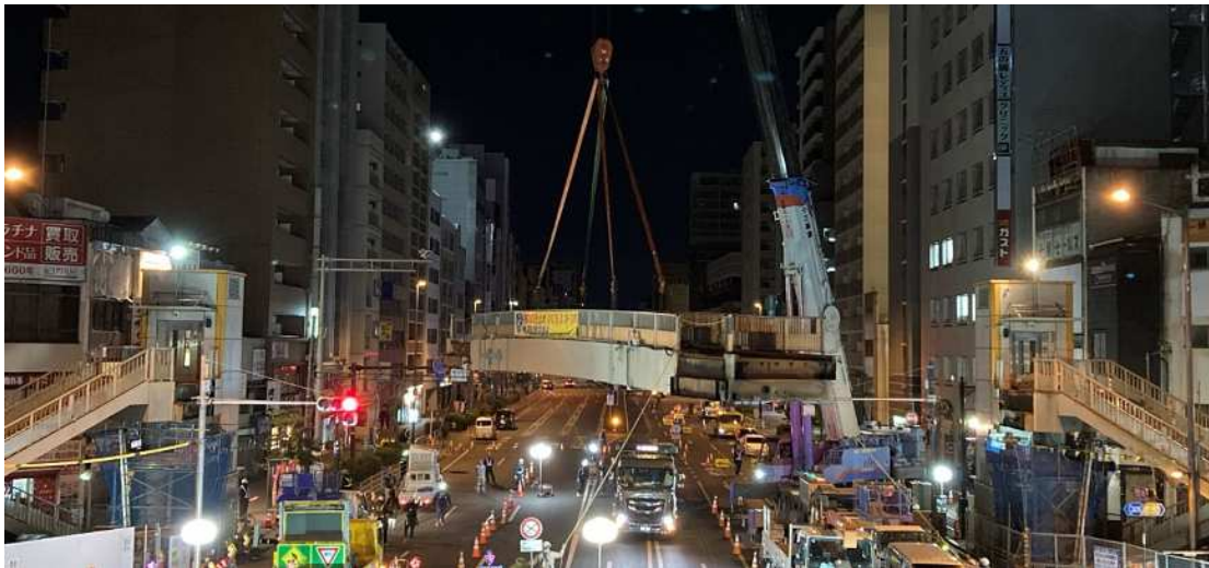
歩道橋撤去工事の様子
